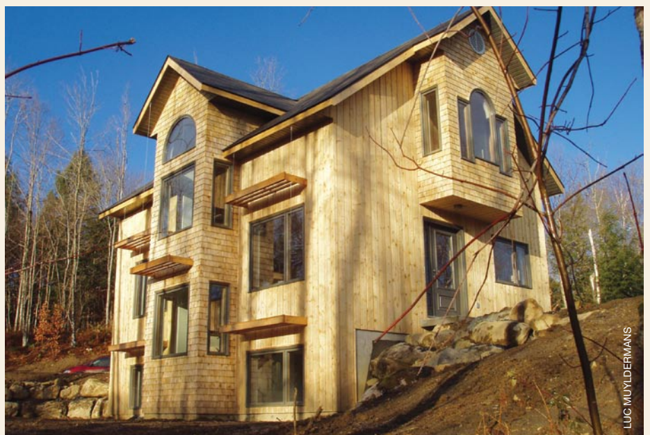
Une maison solaire passive Muyldermans bâtie à Bolton, en Estrie. Notez les éléments d'ombrage au sud.
